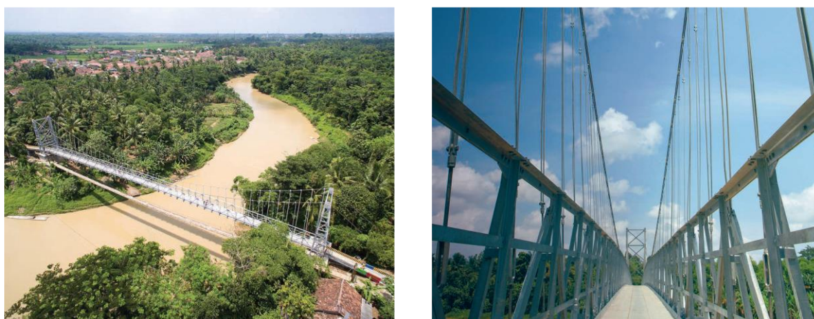
Gambar 6. Jembatan Gantung Rancawiru Lebak dibangun tahun 2015 (Sumber: Kiprah, 2016)
