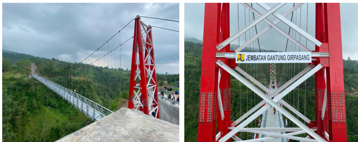
Gambar 7. Jembatan Gantung Giripasang Klaten dibangun tahun 2021
